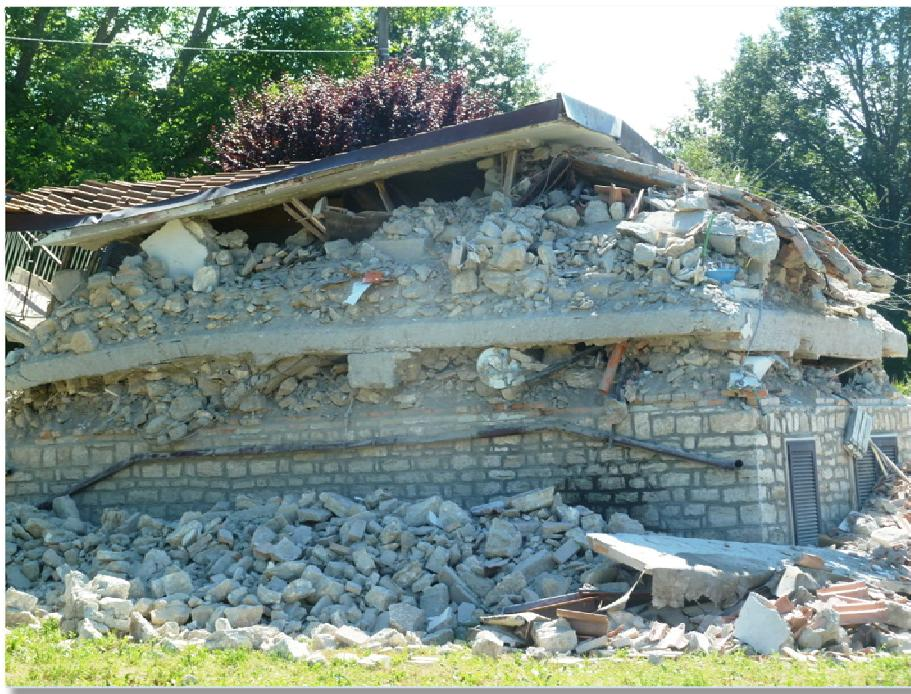
**Fig. 7** - Crollo totale di un edificio in muratura con solai in C.A. (San Lorenzo e Flaviano, Amatrice).
