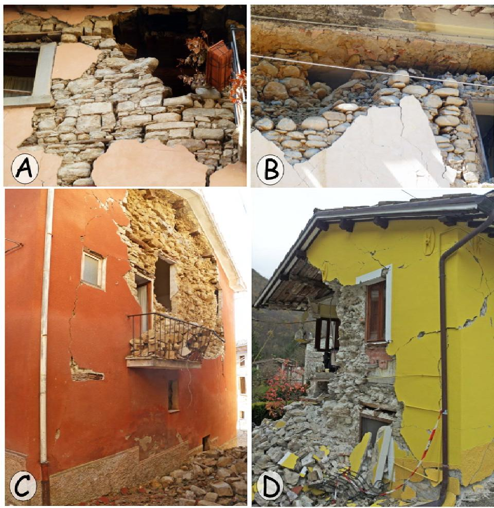
**Fig. 6** - Muratura in pietra con scarsissimo legante. A-B, Retrosi e Sommati (Amatrice, RI), muratura a blocchi squadrati e/o in ciottoli di fiume in materiale arenaceo. C-D, Gualdo e Sasso (MC), muratura mista di pietre arrotondate e squadrate in arenaria e calcareo.
