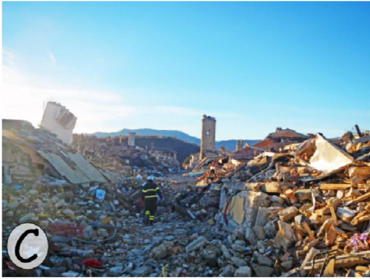
**Fig. 9** - Distruzione progressiva del centro storico di Amatrice (veduta su Corso Umberto, guardando a ovest). A, prima di Agosto (immagine Google Street). B, dopo il 24 Agosto (Is X-XI MCS). C, dopo il 30 Ottobre (Is XI MCS). Si noti il crollo del condominio rosso in C.A., avvenuto con il terremoto del 26 Ottobre, a confronto con l'incredibile resistenza della torre civica medievale, ancora in piedi, a meno dell'altana, dopo mesi di scosse (comprese quelle del 1639).
