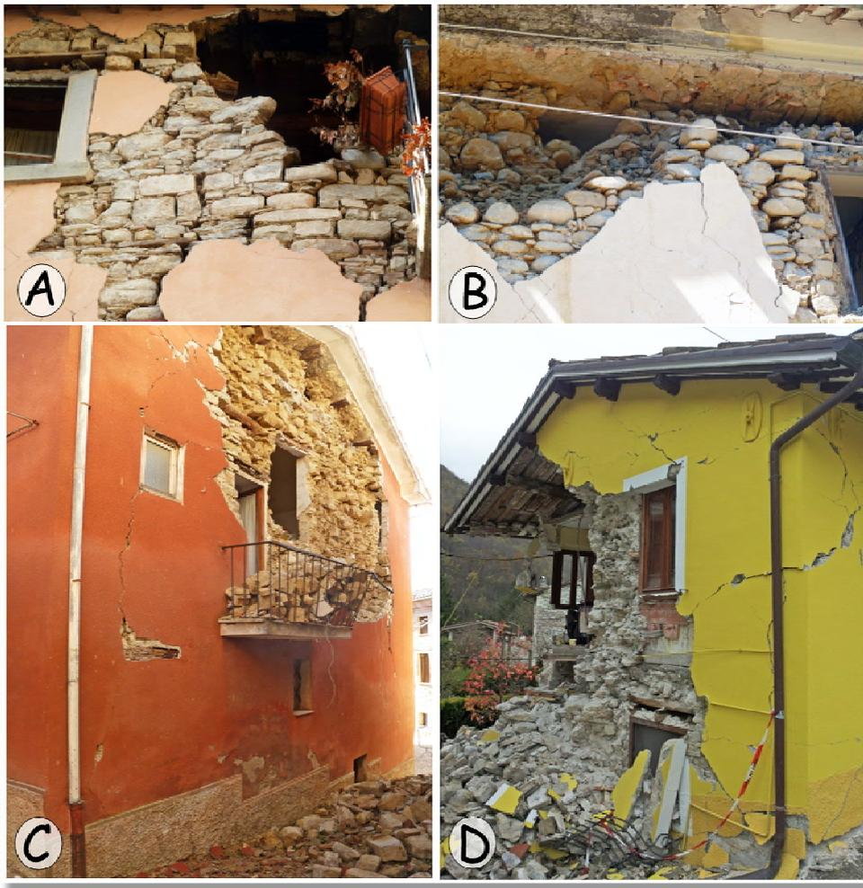
**Fig. 6** - Muratura in pietra con scarsissimo legante. A-B, Retrosi e Sommati (Amatrice, RI), muratura a blocchi squadrati e/o in ciottoli di fiume in materiale arenaceo. C-D, Gualdo e Sasso (MC), muratura mista di pietre arrotondate e squadrate in arenaria e calcare.
