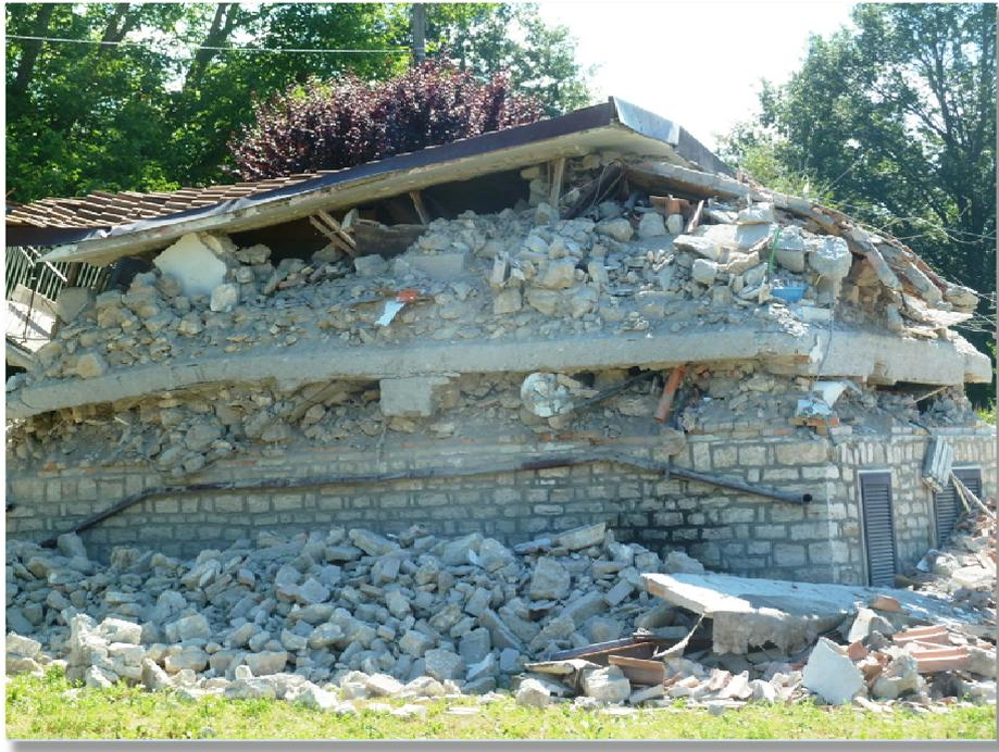
**Fig. 7** - Crollo totale di un edificio in muratura con solai in C.A. (San Lorenzo e Flaviano, Amatrice).
